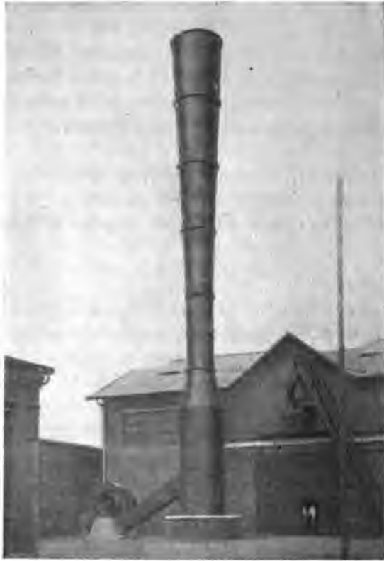
Fig. 85. — Éjecteur pour chaudières à vapeur consommant 10 tonnes à l'heure d'une houille très cendreuse.
